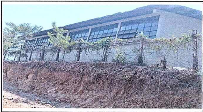
Foto 4: Muro para evitar un derrumbamiento.
